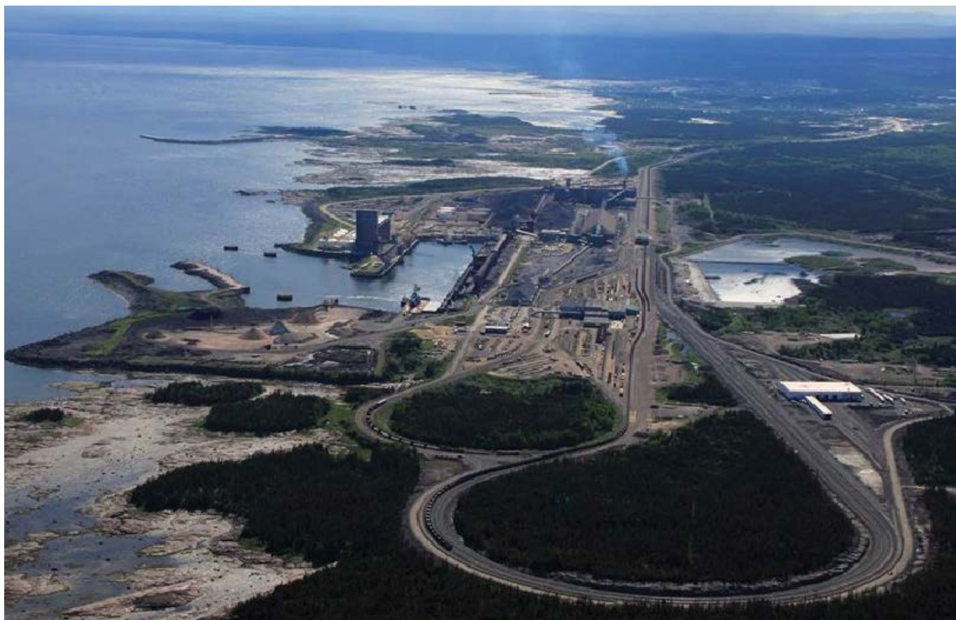
Port et ateliers ferroviaires d'ArcelorMittal à Port-Cartier.
