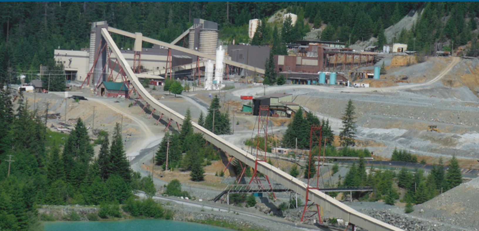
La zone de l'usine de concentration à l'extrémité ouest de l'exploitation Myra Falls de Nyrstar.
